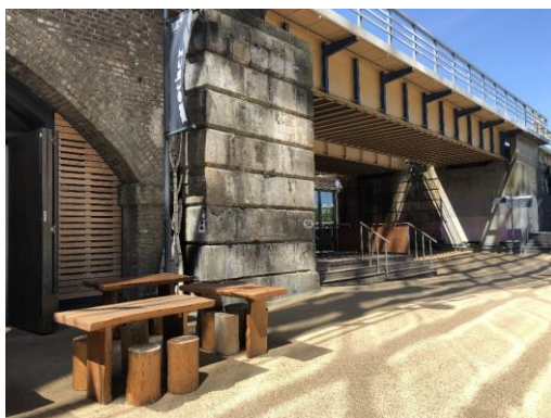
Figura 3. Adecuación de los bajo puentes del tren en el límite de este polígono
