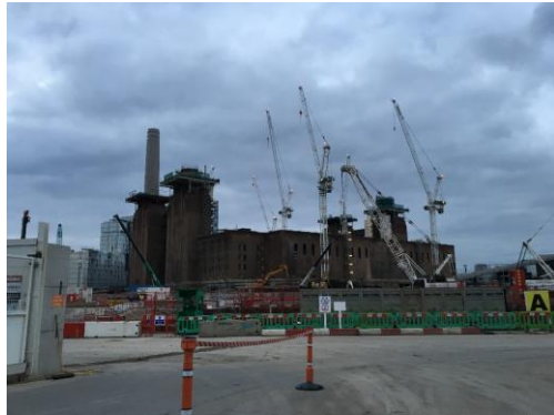
Figura 1. BPS en reconstrucción en 2016
