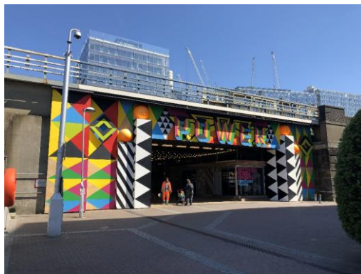
Figura 2. Entrada occidental al polígono en renovación
