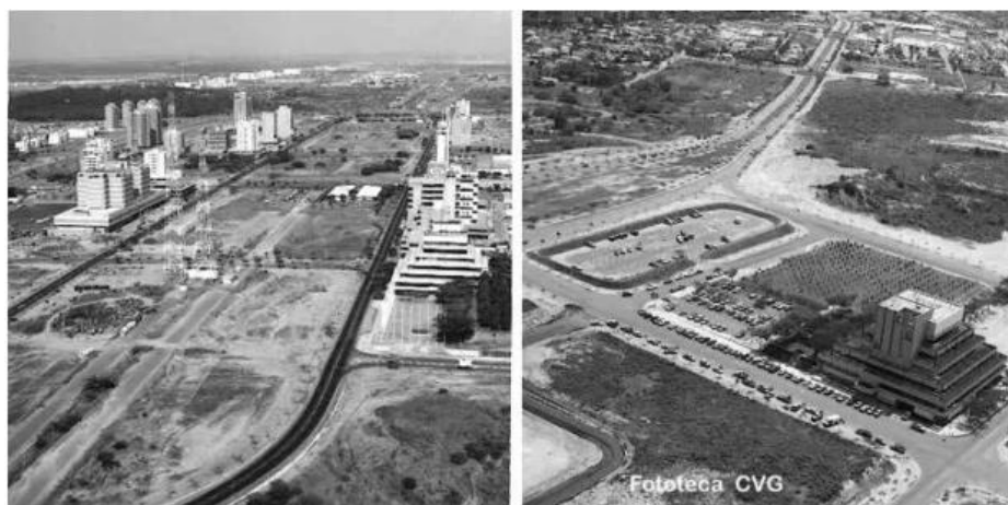
Figura 4. Construcción del edificio sede de la Corporación Venezolana de Guayana (CVG)
