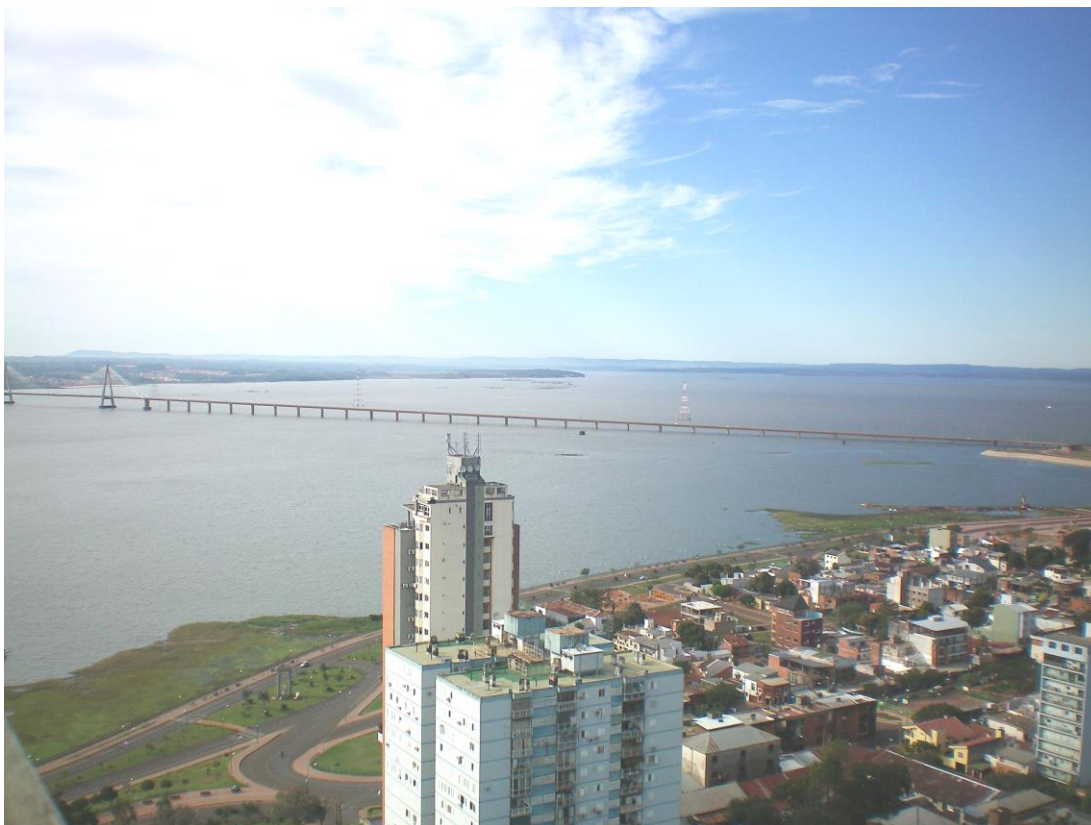
Foto 1. Vista del Puente Internacional desde Posadas.
